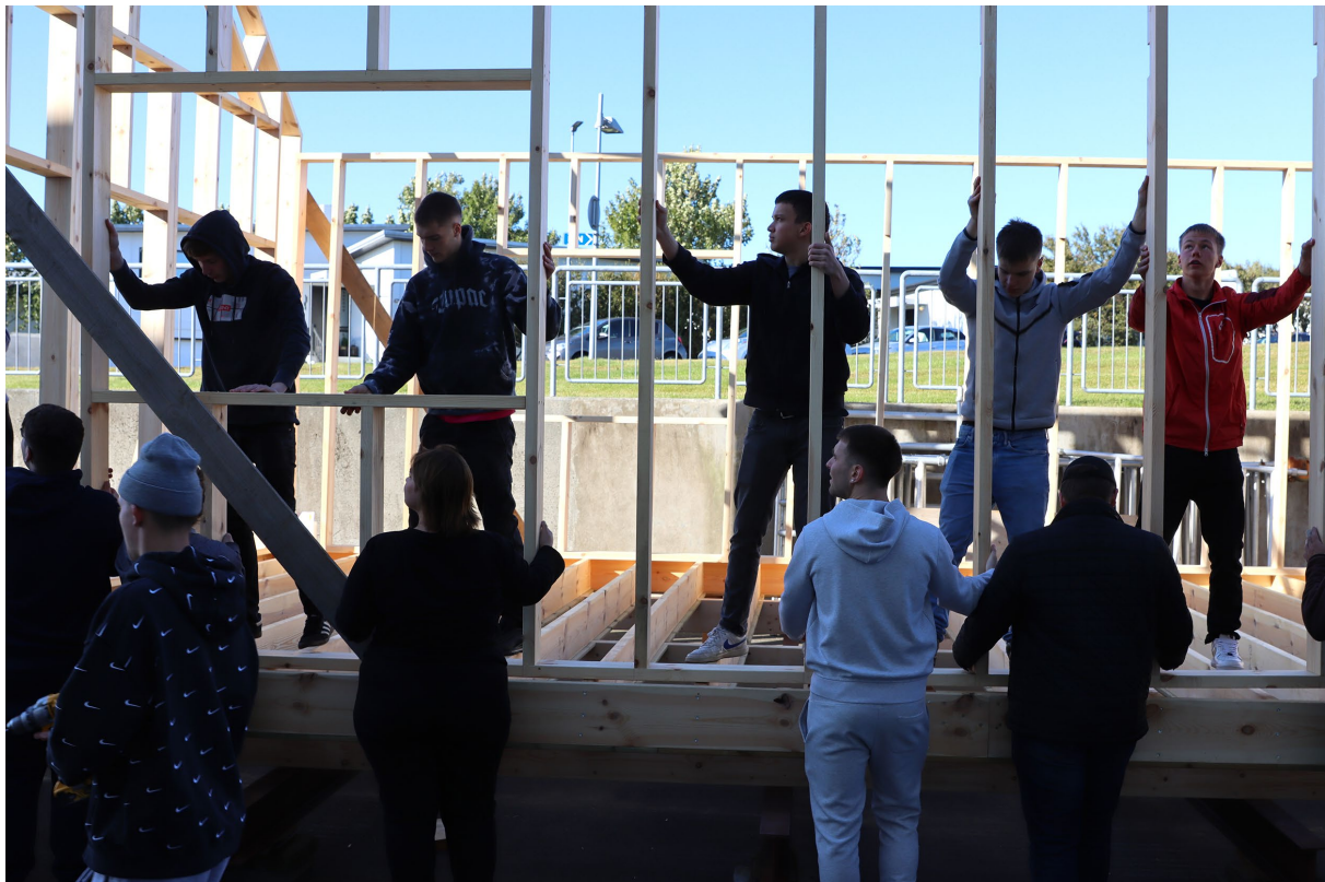
Nemendur í húsasmíði reisa grindina á sumarbústað sem er byggður á skólaárinu.
